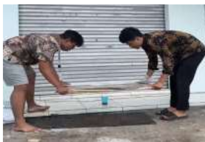
Gambar 2. Penyaringan pasir sebelum dicampurkan
