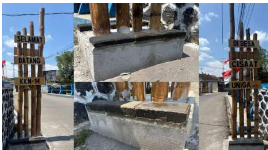
Gambar 5. Pembangunan Plang (gapura) Desa Cisaat dengan material paving block hasil produksi KKN
