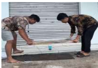
Gambar 2. Penyaringan pasir sebelum dicampurkan
